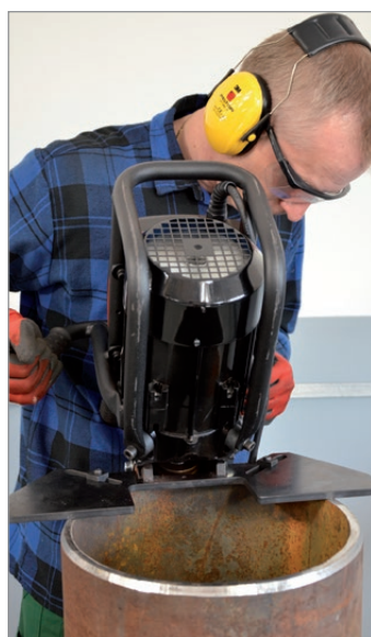
Anfasen von Rohren
