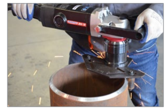
Anfasen von Rohren
